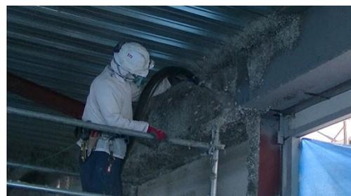
写真1 耐火被覆吹付作業
