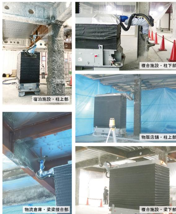
写真 8 吹付ロボットによる現場施工
