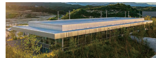
河村電器産業株式会社 郡山工場 厚生棟「AQUIRIO」(福島県)
